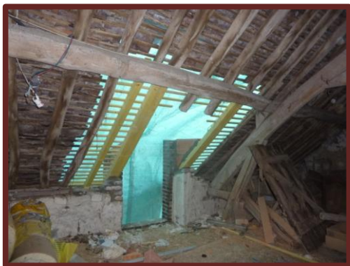
Dépose de la lucarne
