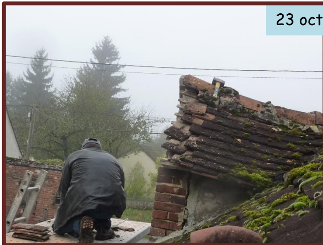
Dépose de la lucarne
